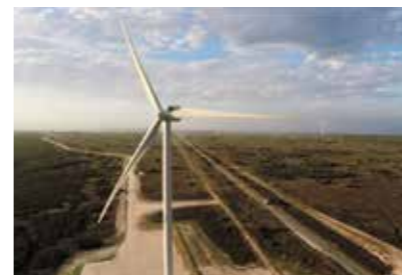
Parc éolien de Grassridge
