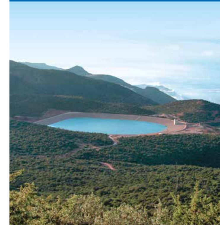
Station de transfert d'énergie par pompage d'Afouer (Maroc)
